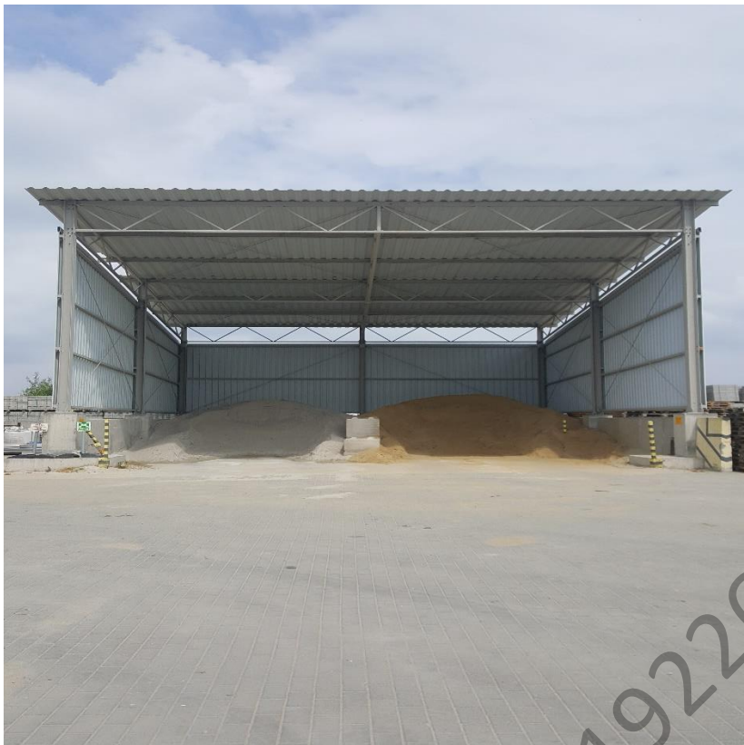
Istniejące zadaszanie boks magazynu kruszyw (żwiru) – widok od przodu
